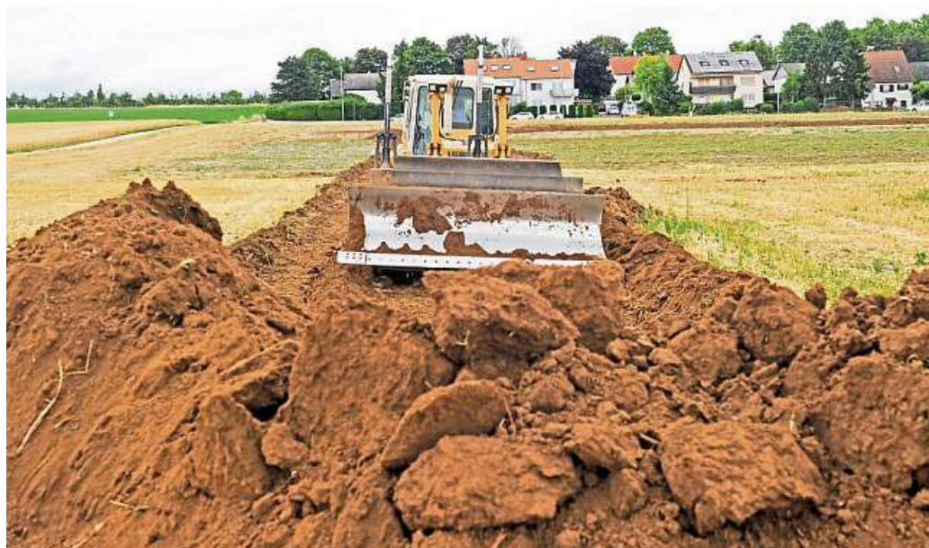
Im Sommer vergangenen Jahres waren die Bauarbeiten gestartet.
